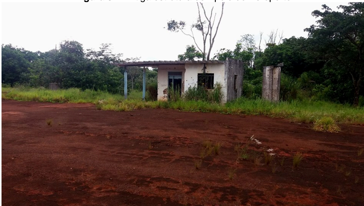
Figura 31. Antiga estrutura de Apoio do Aeroporto
