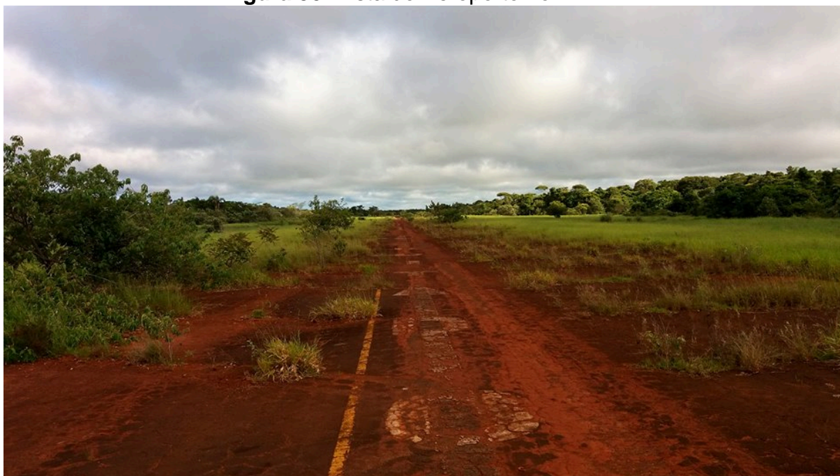
Figura 30. Pista do Aeroporto no PEMD
