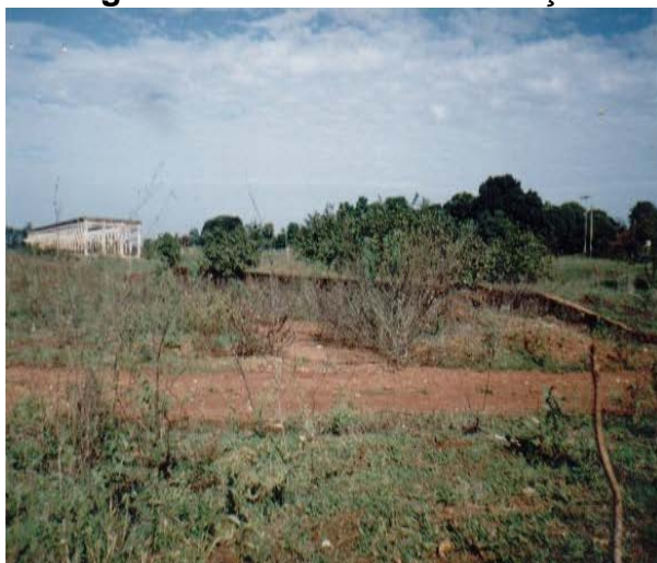
Figura 21. Plataforma da Estação
