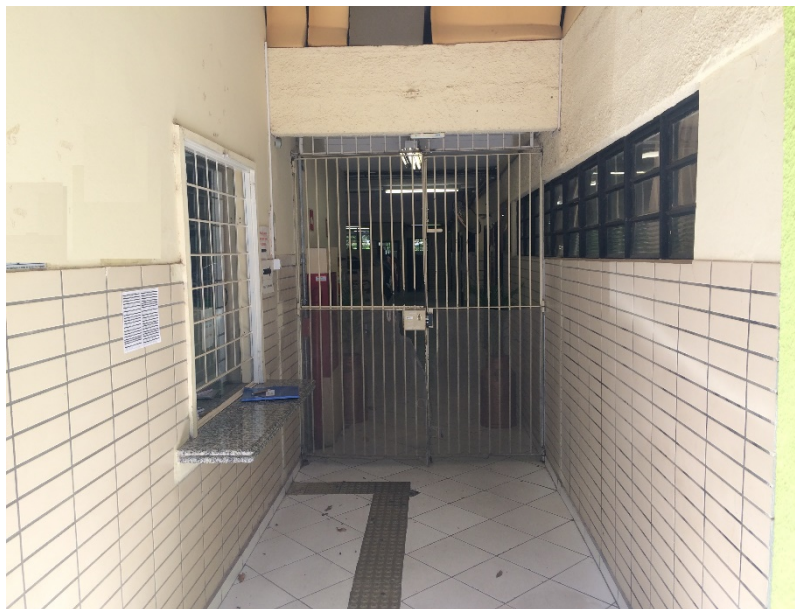
Figura 1 - Entrada Principal da Escola
