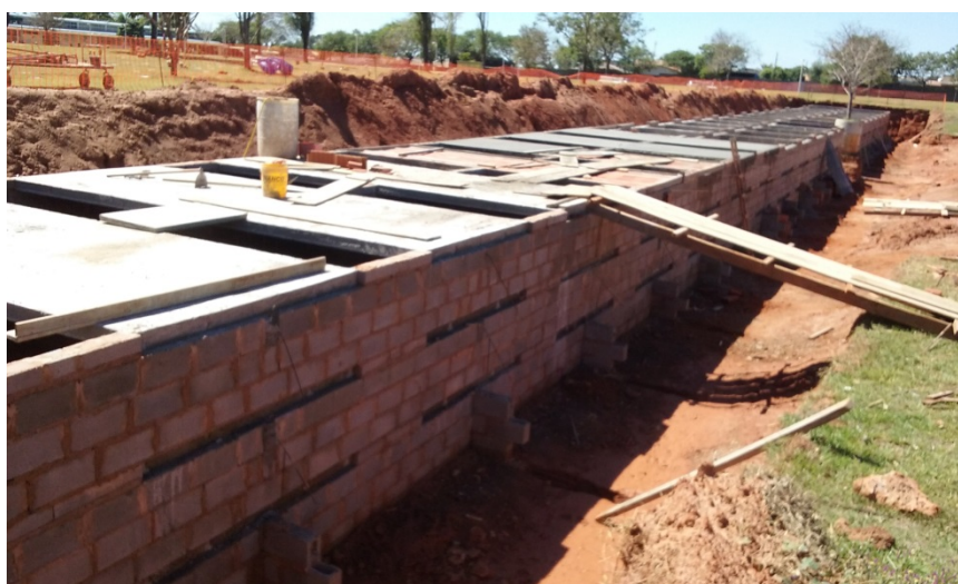
FIGURA 7 - Construção dos túmulos no cemitério B
