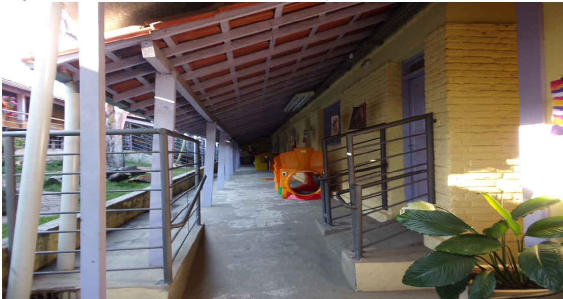
Imagem 8: Unidade I do CAIS- Entrada com rampa
