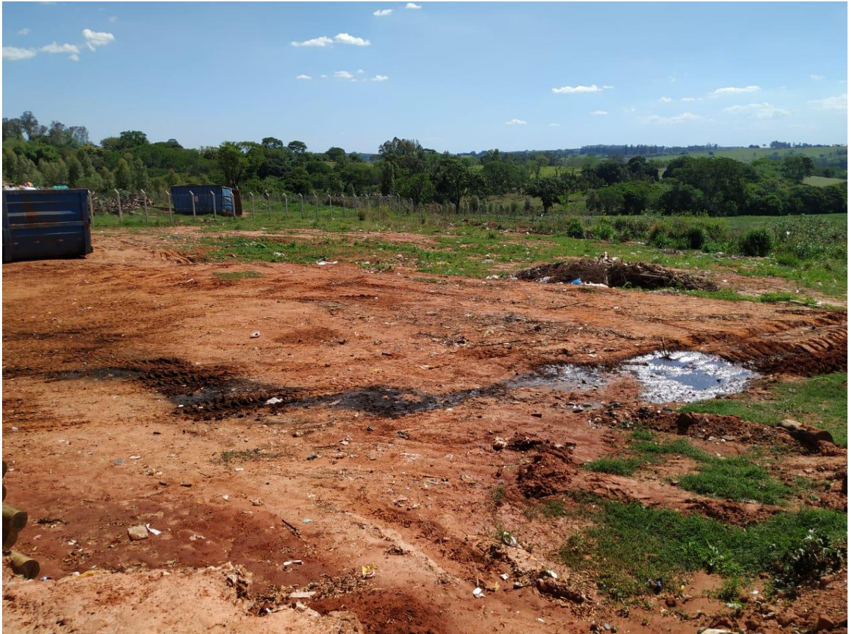
Figura 16 - Aterro de Pirapozinho local de transbordo poça de chorume
