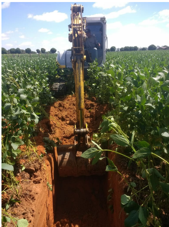
Figura 4. Abertura de trincheiras com a minirretroscavadeira tipo bobcat.
