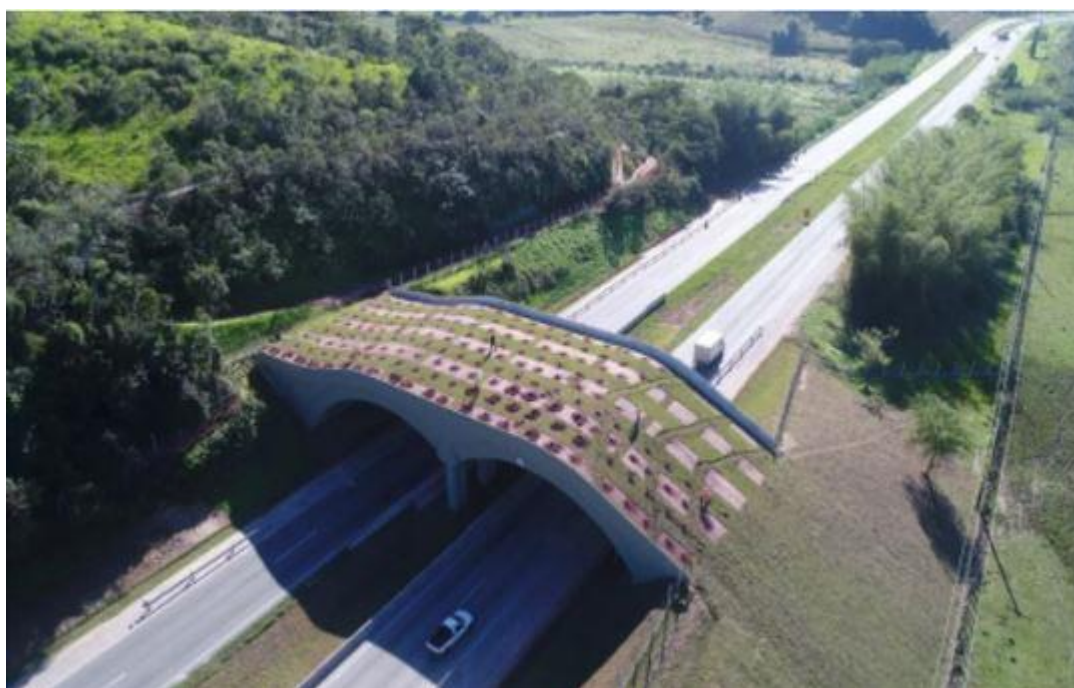
Figura 19 - Primeiro viaduto vegetado em rodovia federal do Brasil fica na BR-101, em Silva Jardim, no RJ
