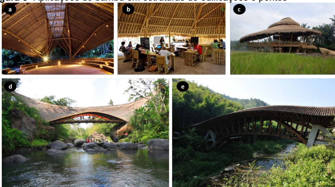
Figura 3- Aplicações do bambu em estruturas de edificações e pontes
