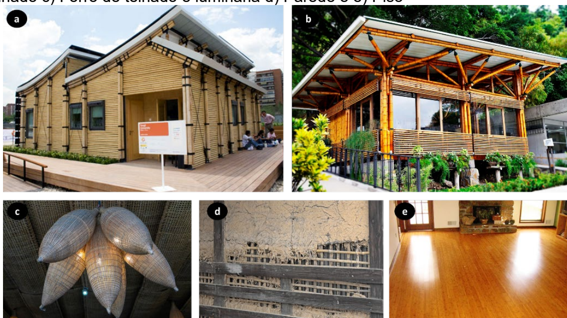
Figura 2- Aplicações de construção de bambu em a) Parede b) Estrutura de parede e telhado c) Forro de telhado e luminária d) Parede e e) Piso
