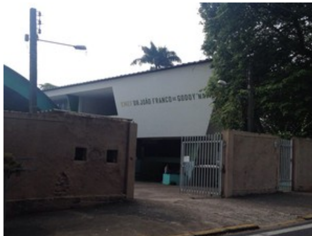
Figura 24 – Vista atual da escola e acesso principal
