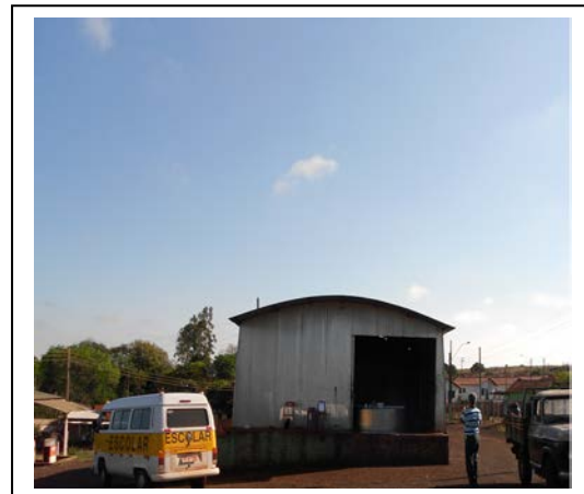
FIGURA 5 - Barracão com os tanques de resfriamento da Sede da Associação dos Produtores Rurais de Agissê – Rancharia – SP Fonte: Pesquisa de Campo (10/10/2012) Autora: Santos, Eliane Silva dos
