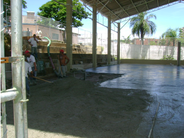
Quadra poliesportiva durante reforma e cobertura
