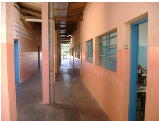
Bloco Inferior (Salas de aula)
