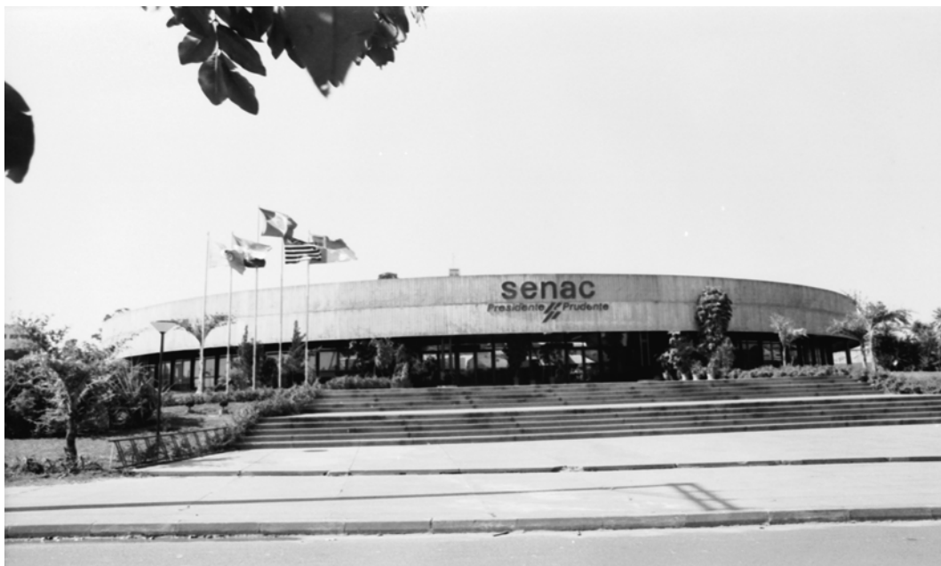
FIGURA 13 - Fachada da Unidade na data da reinauguração
