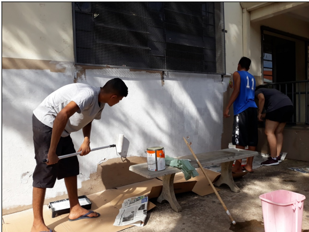
Figura 16 - Foto do lixamento e pintura do muro da escola
