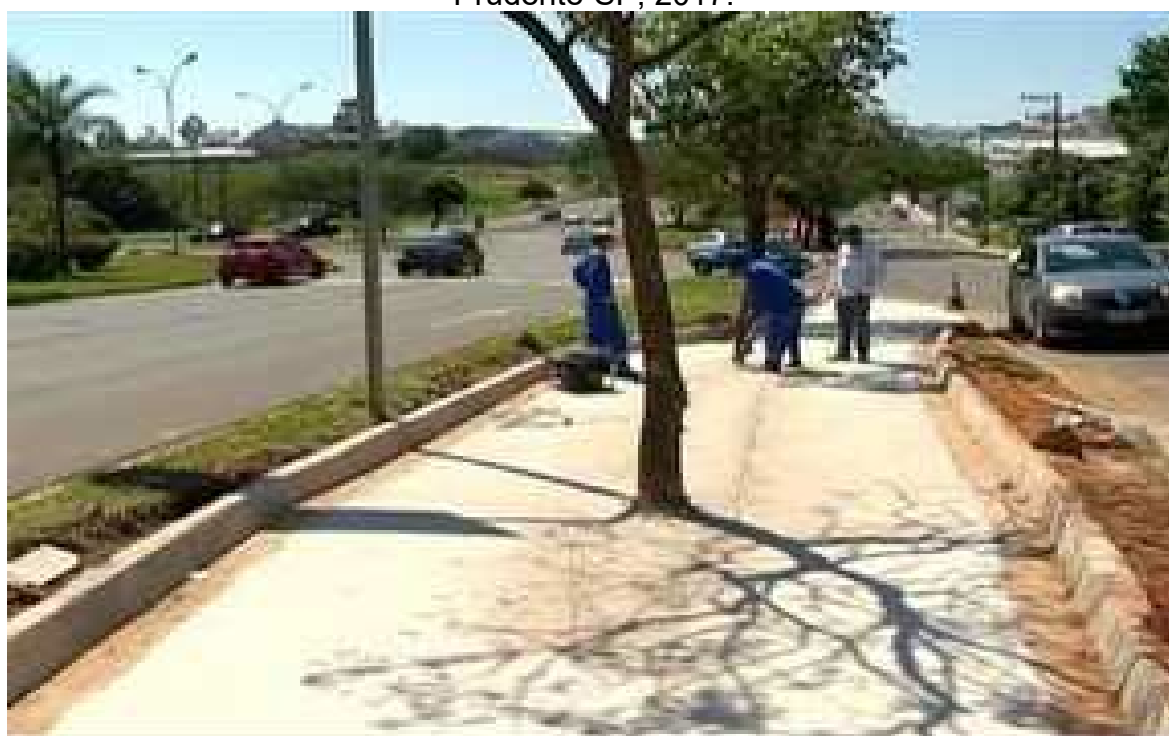
Figura 17 - Readequações no trecho 3, no percurso do Cristo (Avenida Manoel Goulart), promovendo canteiro permeável em torno das árvores - Presidente Prudente-SP, 2017.
