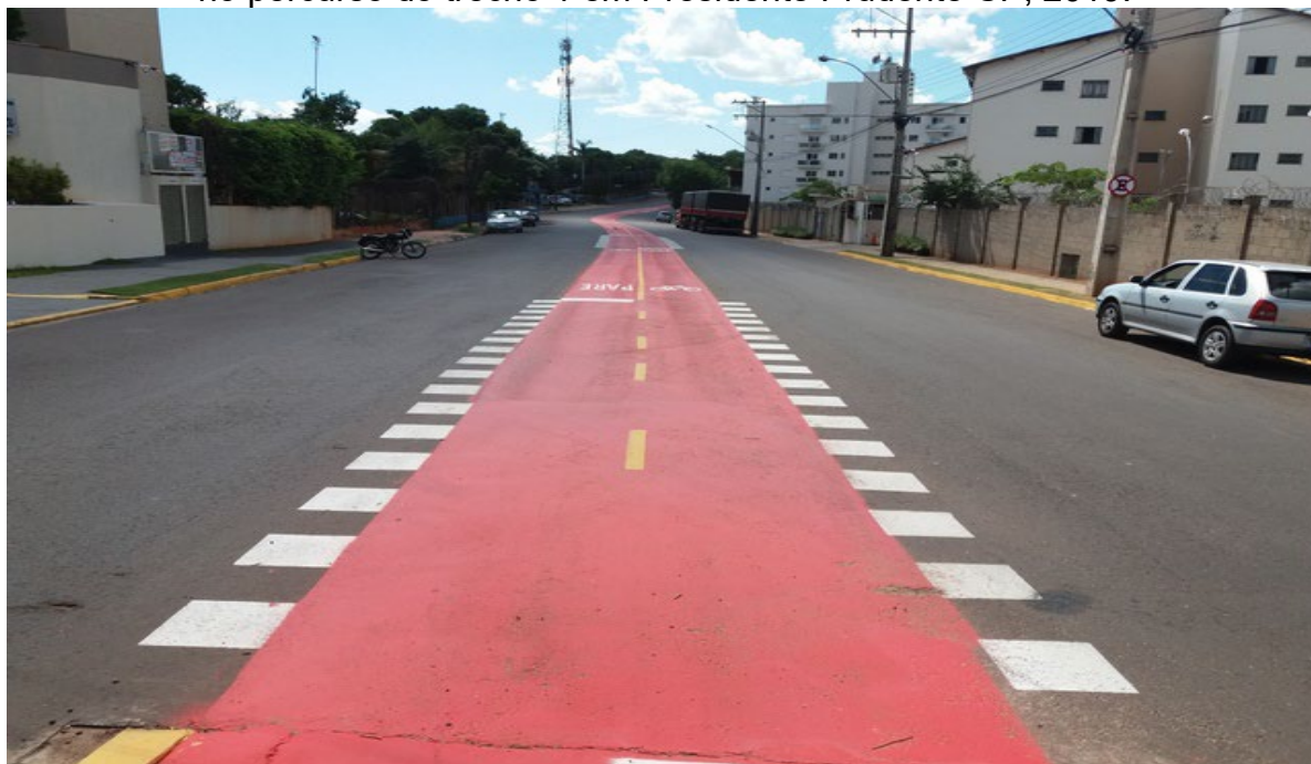
Figura 14 - Falta de gradis, apenas tinta no asfalto demarcando o espaço da ciclovia no percurso do trecho 1 em Presidente Prudente-SP, 2019.
