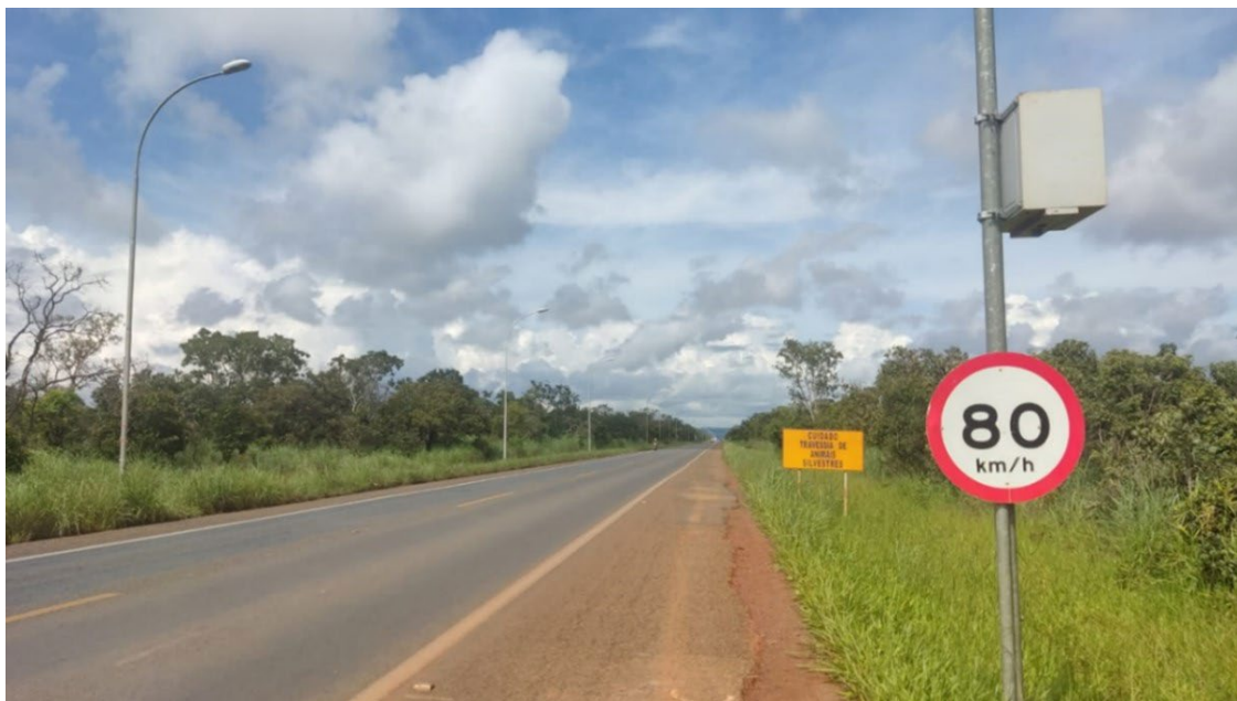
Figura 13- Rodovia Distrital DF-128 km 4,5, próximo à ESECAE
