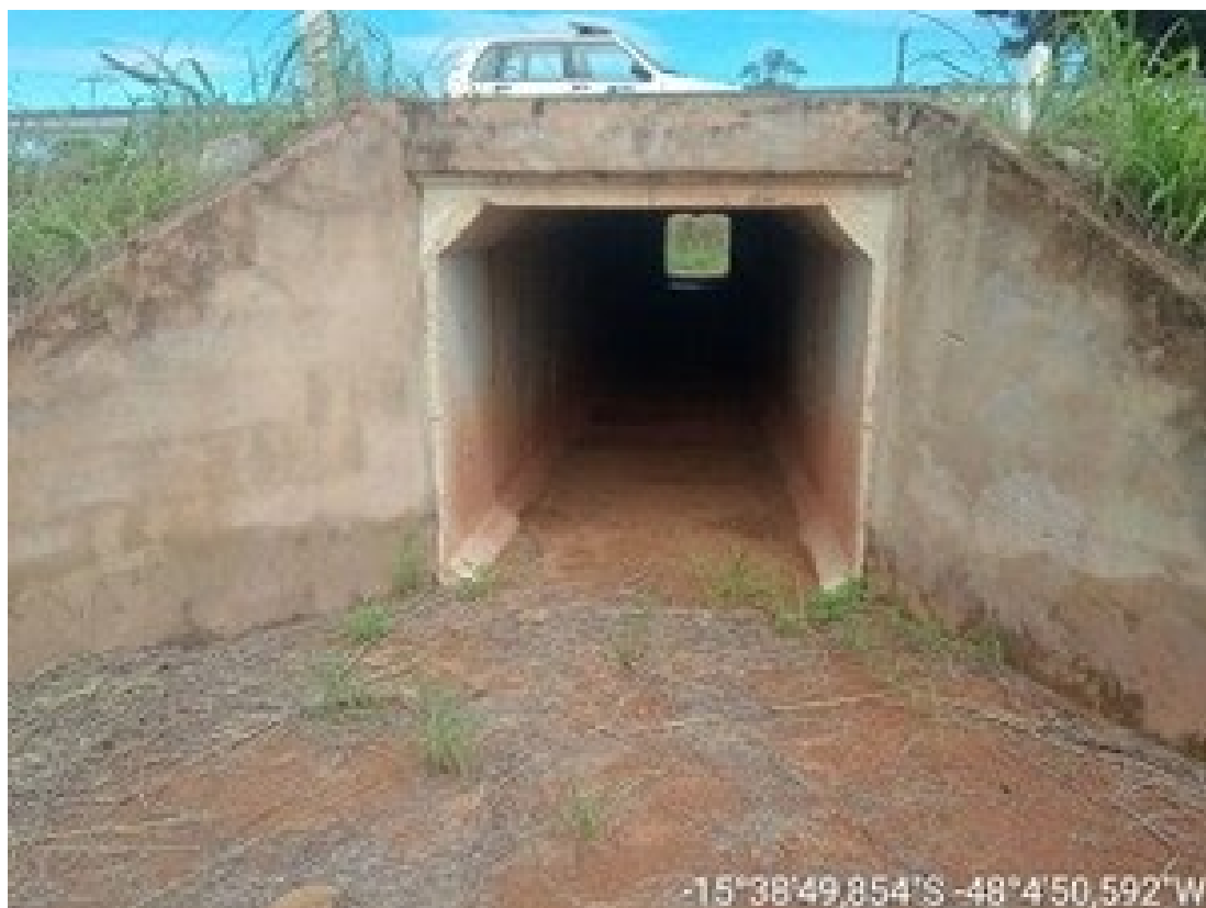
Figura 31- Passagem de Fauna - Rodovia Distrital DF-001, km 100,1 (PNB)
