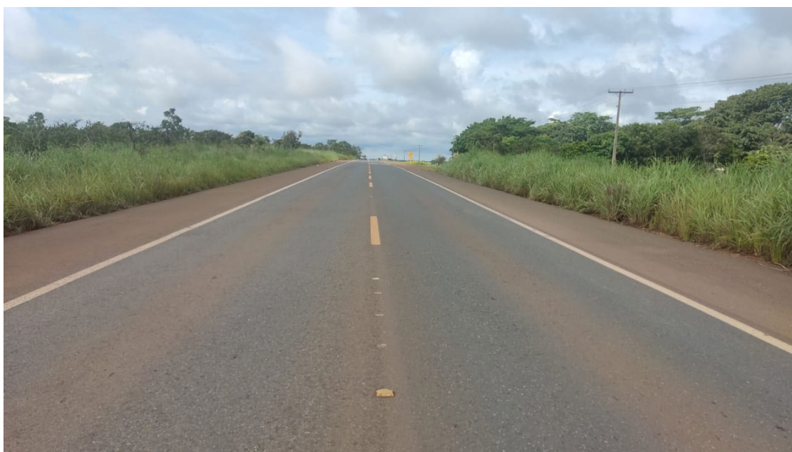
Figura 14- Rodovia Distrital DF-345 km 1,5, próximo à ESECAE
