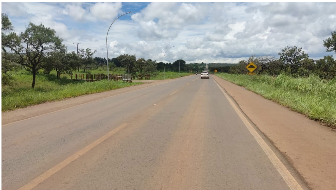
Figura 12- Vegetação Lindeira na Rodovia Distrital DF-001, próximo ao PNB
