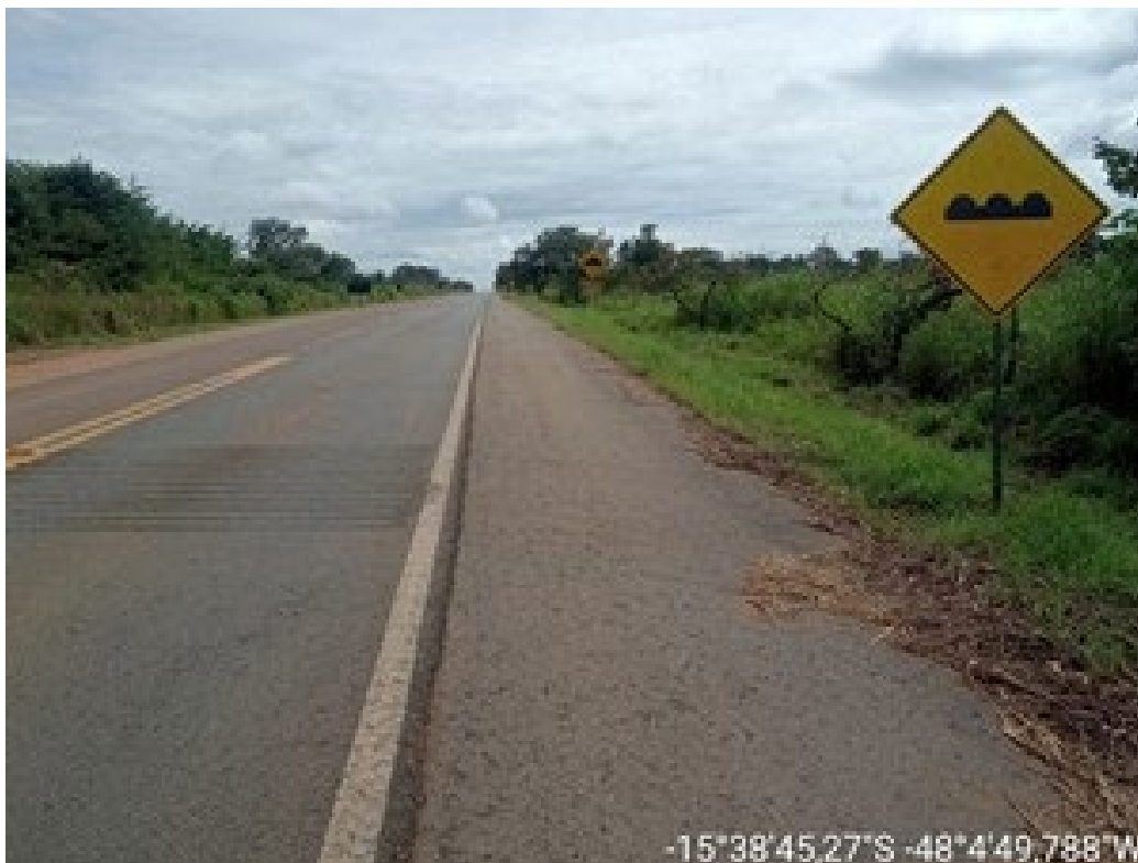
Figura 28- Sinalização vertical - Sonorizadores - DF-001 (PNB)
