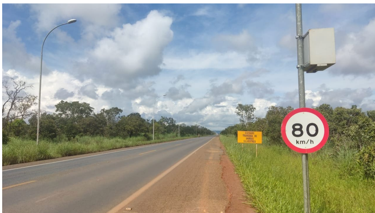
Figura 32- Sinalização na DF-128 km 4,5 (ESECAE)
