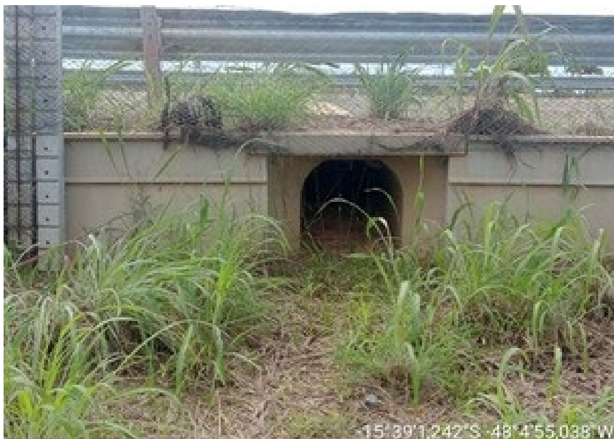
Figura 33- Passagem para herpetofauna tipo túnel climático na DF001 - km 99.8 (PNB)
