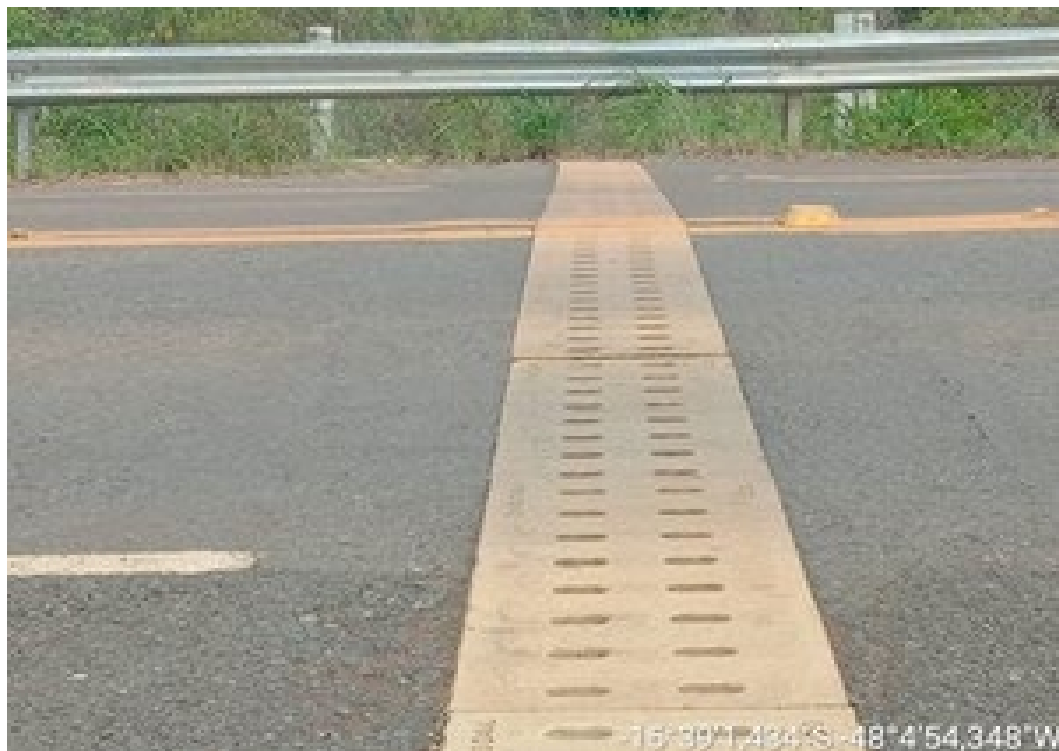
Figura 26- Passagem de fauna tipo túnel climático - DF-001 (PNB)
