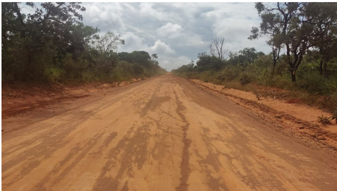
Figura 15- Rodovia Distrital DF-205, próximo à ESECAE
