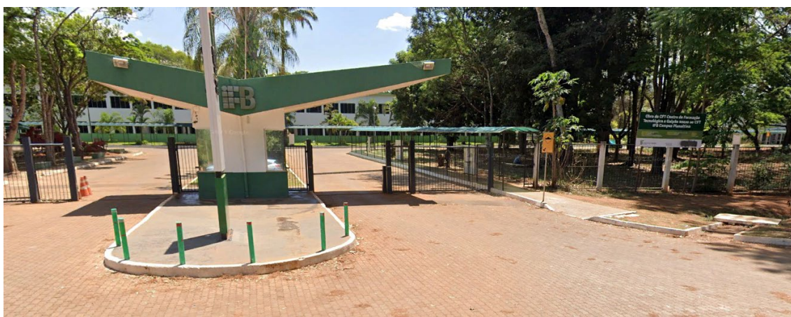
Figura 3- Vista geral da entrada principal do Instituto Federal de Brasília - Campus Planaltina.
