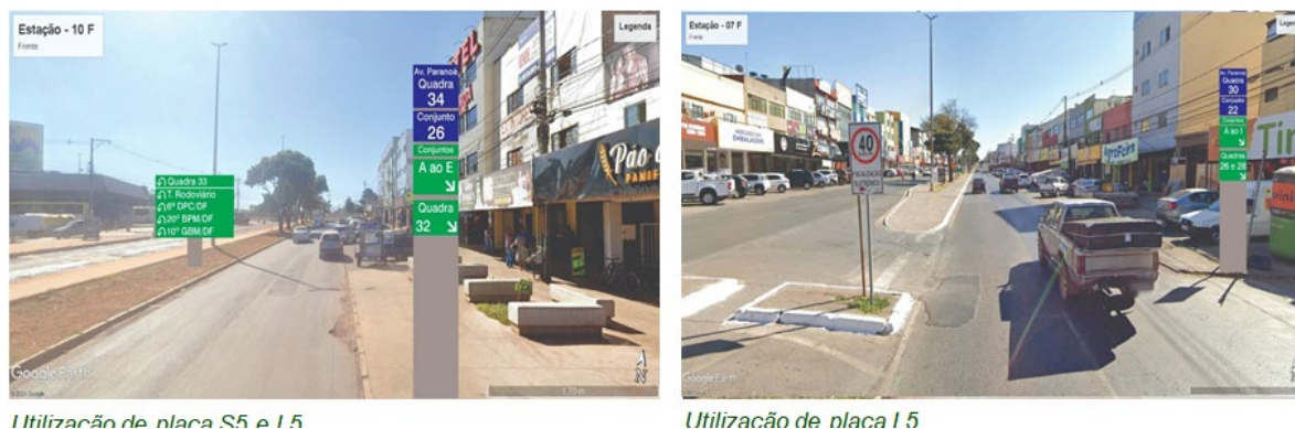
Utilização de placa S5 e L5
