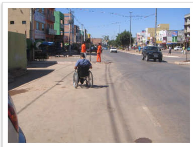
Figura 36— Ausência de rota acessível para cadeirante
