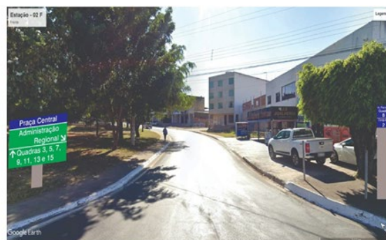
Utilização de placa S5 e L5
