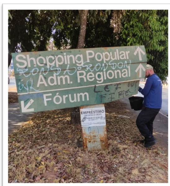
Figura 16— Placa metálica danificada sendo substituída
