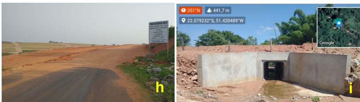
Figura 14 (h) — Implantação do arruamento do Park Residencial Momi, (i) Túnel da obra
