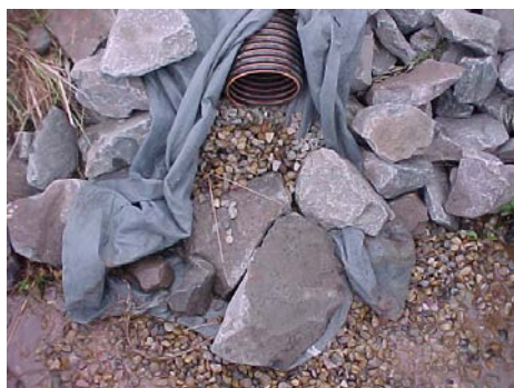
Figura 23 - Detalhe da construção da drenagem e aspecto geral após a conclusão da recuperação da erosão.
