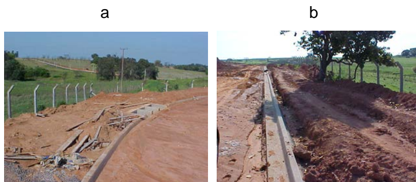
Figura 31 - Área de Preservação Permanente, remanescente entre o meio fio e a cerca de alambrado, onde devem ser plantadas árvores de porte grande.
