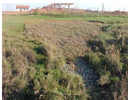
Figura 23 - Detalhe da construção da drenagem e aspecto geral após a conclusão da recuperação da erosão.
