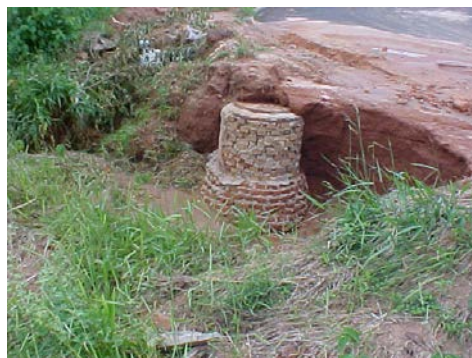
Figura 28 - Rede de drenagem danificada pelas águas pluviais.
