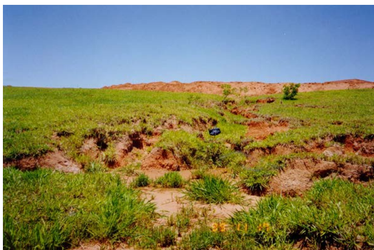
Figura 6 - Erosão superficial no empreendimento Maré Mansa.
