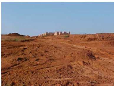
Figura 30 - Solo exposto em função da implantação do Conjunto Habitacional.
