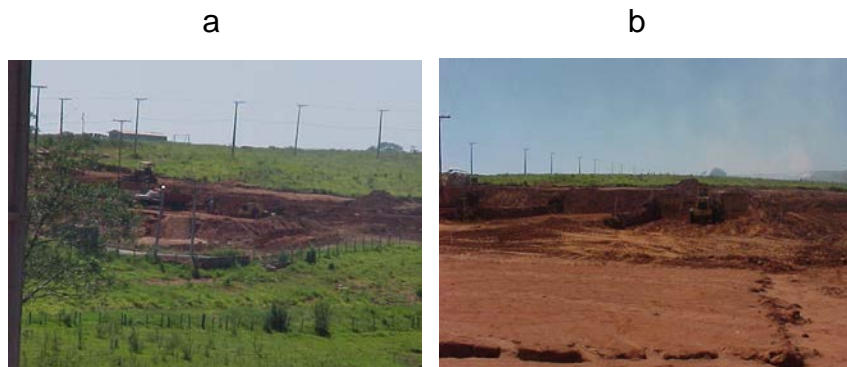
Figura 29 - Segunda fase de implantação de unidades habitacionais, com grande movimentação e exposição de solo.
