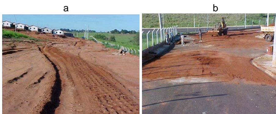
Figura 32 - Grandes áreas de exposição do solo e solo sobre o piso asfáltico.
