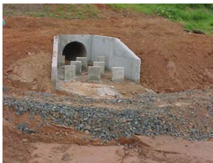
Figura 24 - Escada de dissipação construída no córrego da Malandra.
