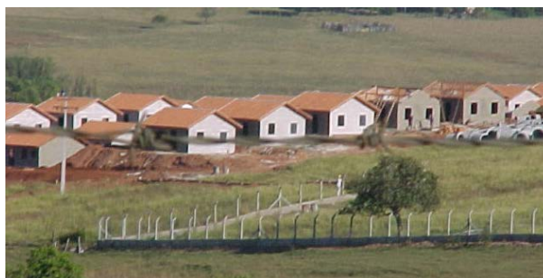
Figura 12 - Cerca de alambrado sendo construída no setor sul do Residencial Maré Mansa.
