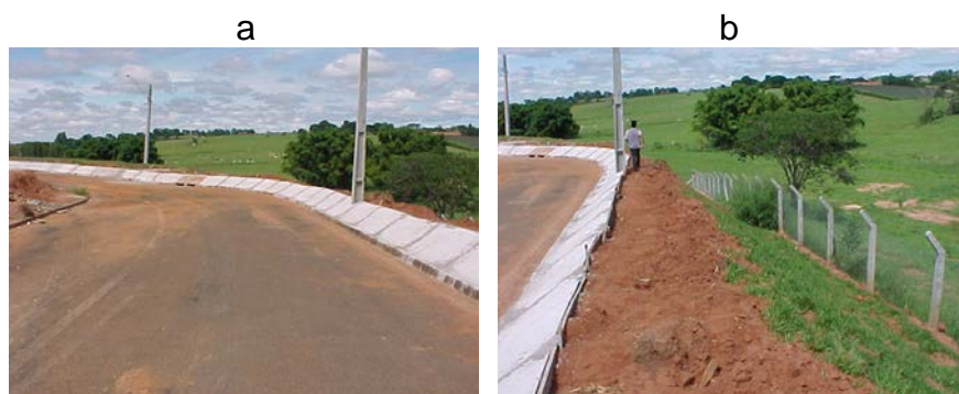
Figura 18 - Elevação da calçada como medida mitigadora dos processos erosivos.
