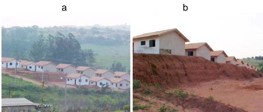
Figura 35 - Desnível acentuado entre as casas e a inclinação do talude.
