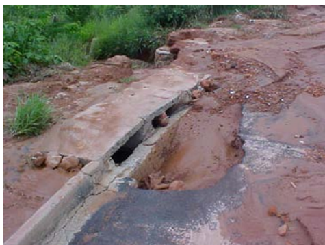
Figura 28 - Rede de drenagem danificada pelas águas pluviais.
