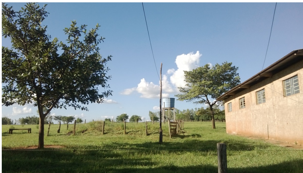
FIGURA 41 – Poço artesiano e aproveitamento de água
