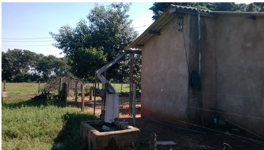
FIGURA 34 - Captação de água da chuva através de calha construída pelo produtor 02
