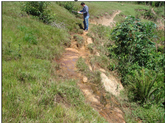
FIGURA 36 – Afloramento do freático junto ao maciço rochoso (KaIV) próximo à cabeceira do córrego do São Pedro.
