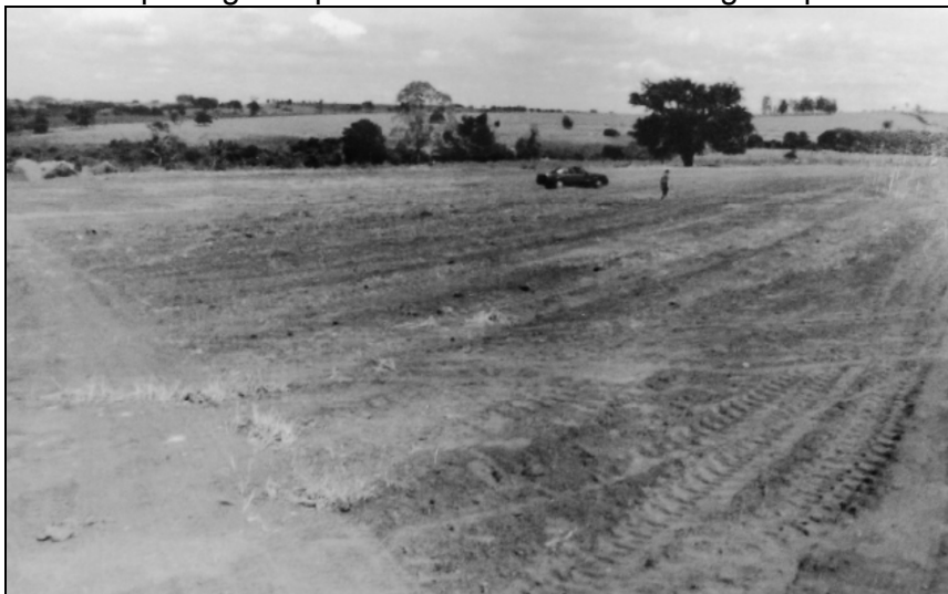
FIGURA 17 – Terraplanagem após o encerramento do antigo depósito de lixo.
