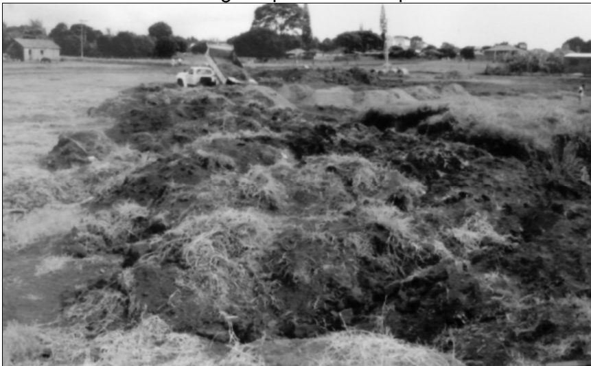
FIGURA 16 – Aterramento do antigo depósito de lixo próximo à cidade.
