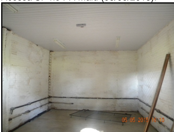
FIGURA 40 – Imagem interna do local destinado à instalação de sala do Acessa SP no PA Malu (05/05/2015).
