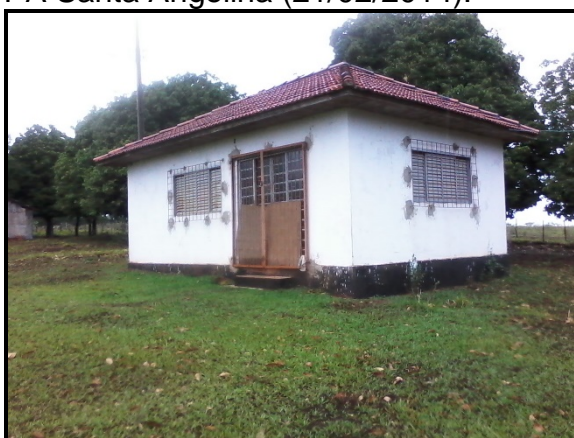
FIGURA 16 – Imagem externa do local destinado a instalação da sala digital no PA Santa Angelina (21/02/2014).
