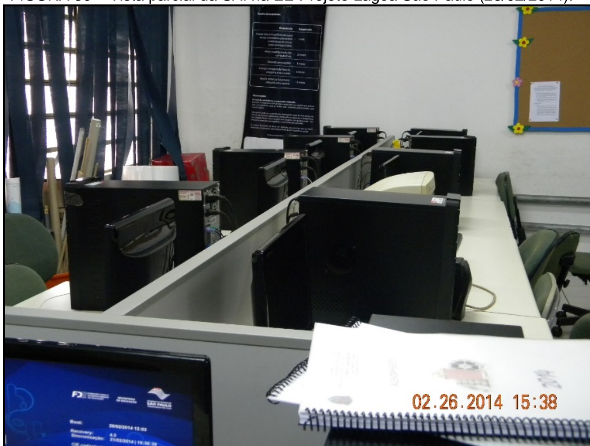
FIGURA 30 – Vista parcial da SAI na EE Projeto Lagoa São Paulo (26/02/2014).
