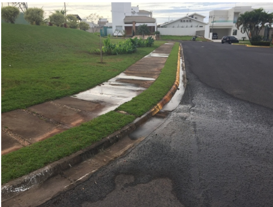
FIGURA 37 - Área permeável do Residencial Damha Beatriz, que se mostra insuficiente para absorver o montante de água pluvial em chuvas mais fortes
