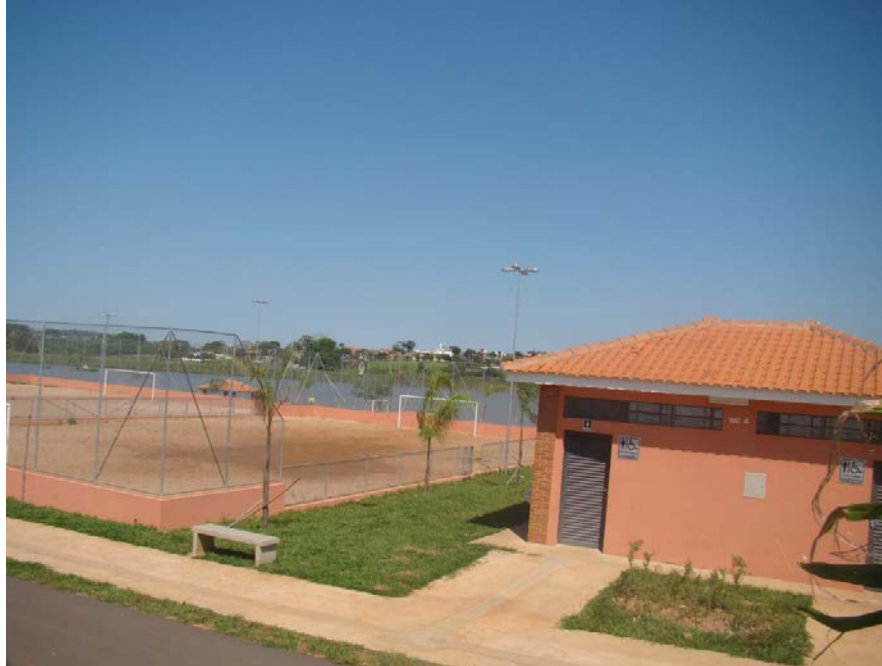
FIGURA 28 - Infraestrutura implantada no Balneário da Amizade: Banheiros e quadras de areia
