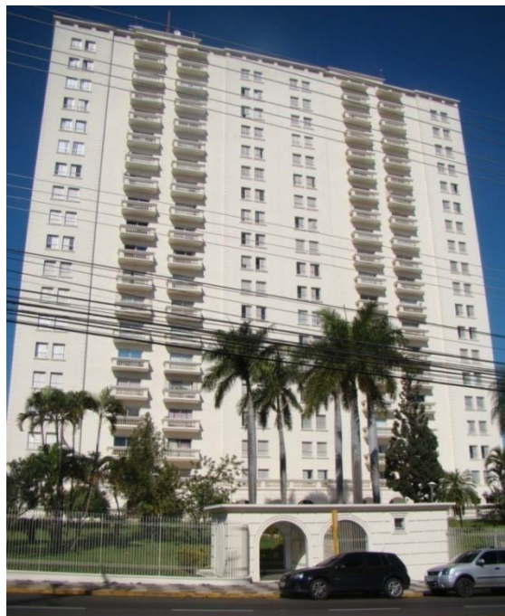
FIGURA 11 - Edifício Laudério Leonardo Botigelli
