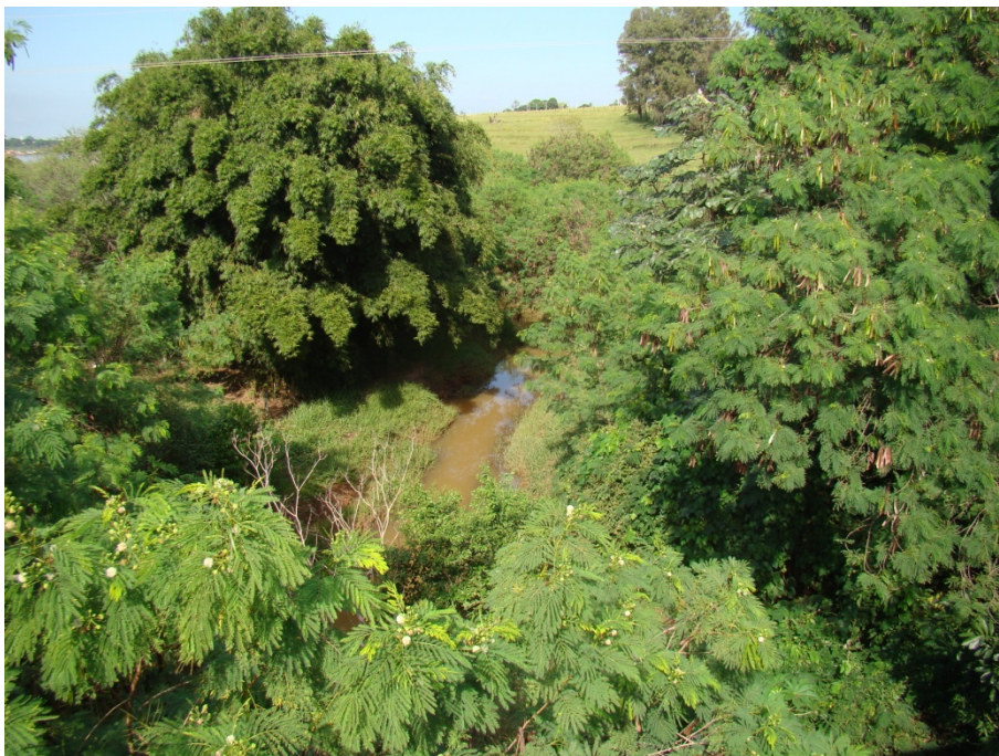
FIGURA 32 - Vista do Córrego do Limoeiro sob a ponte da Rod. Arthur Boigues Filho no sentido da jusante
