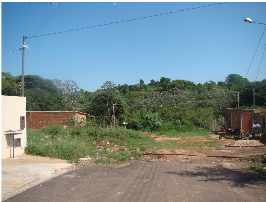
FIGURA 40 - Edificações irregulares construídas sobre a área verde do Córrego do Limoeiro
