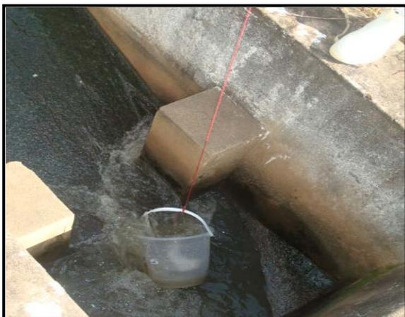
**FIGURA 03.** Tratamento preliminar (caixa de areia e gradeamento)
