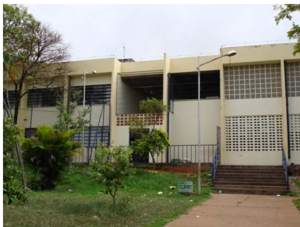
FIGURA 1 - Fachada principal da escola 1 Fonte: A autora (2008)
