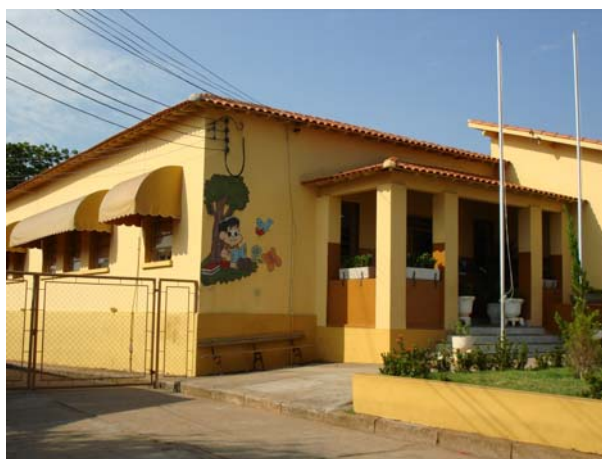
FIGURA 2 - Fachada principal da escola 2 Fonte: A autora (2008)
