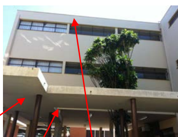
Pátio coberto sobre pilotis. Detalhes das janelas dos corredores nos Pisos II e III.
