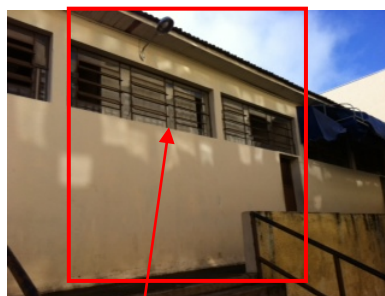
Vista externa da sala de vídeo, vitrões que não possibilitam uma boa ventilação e iluminação natural.
