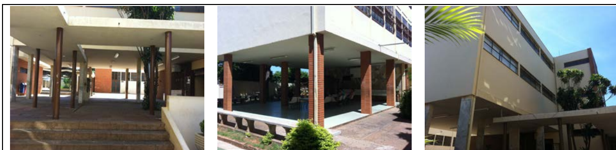
FIGURA 2 - EE “Antônio Marinho de Carvalho Filho” detalhes da arquitetura escolar da década de 60 – pilotis, pátios e marquises.
